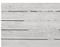
TX-022 2502 Beton Tablas
